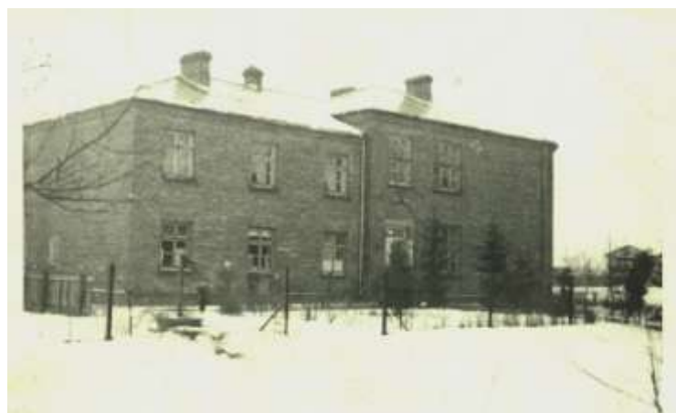
Budynek szkoły z 1937 r.
